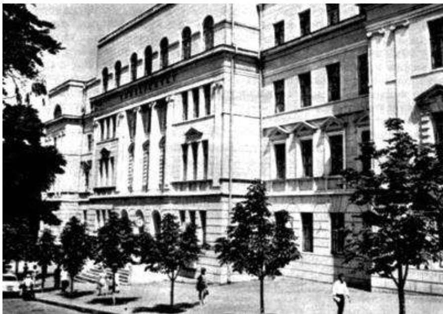
Навчальний корпус № 2 ДДУ після реконструкції (1936)
